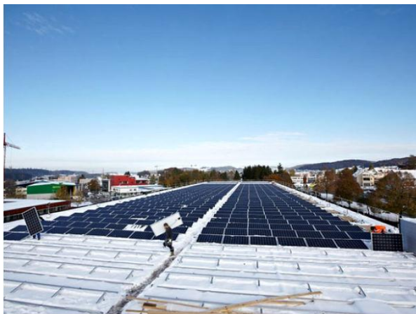
Abb. 7 Installation der Photovoltaikanlagen auf dem Sammlungszentrum Affoltern des Schweizerischen Nationalmuseums
