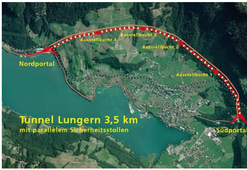
Abb. 15 ASTRA Tunnel Lungern-Pilotprojekt
